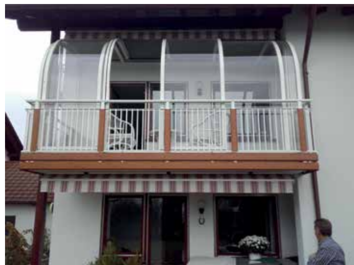
"Die integrierte Beschattung läuft am feststehenden Element und dient somit als Markise. Diese ist manuell oder auch elektrisch zu bedienen".
